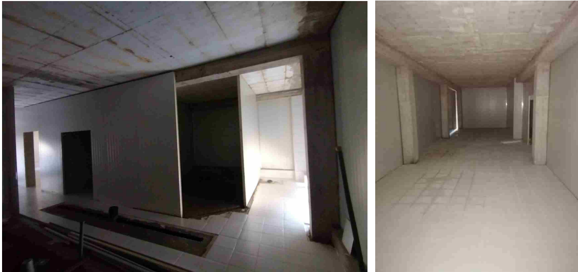
Slika 2.4. Unutrašnji izgled objekta u kojem se planira prerada mesa
