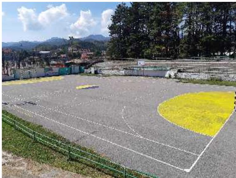
Ukupna površina igrališta na poligonu iznosi  $1200\text{ m}^2$ , a predviđen je za rukomet, mali fudbal i košarku. Ograda je betonskim zidom sa gledalištem na istočnoj i zapadnoj strani dimenzija  $30/80\text{ m}^2$  i  $40/80\text{ m}^2$ . Kapaciteta je 1000 mjesto. Posjeduje adekvatnu rasvjetu, dok su tribine u veoma lošem stanju.
