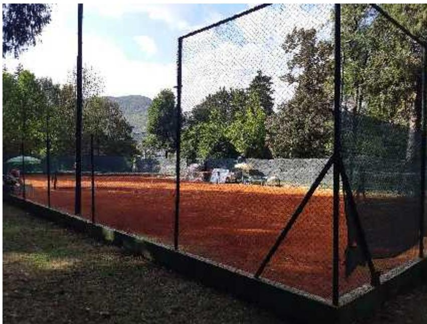
Pod vlasništvom d.o.o "Sportski centar Cetinje" nalazi se i teniski teren sa zemljanim podlogom. Teren je ogranjen s ogradom dimenzija  $39 \times 18 \text{ m}^2$ , a samo tenisko igralište je dimenzija  $23,77 \times 10,97 \text{ m}^2$ . Teren nema adekvatno osvjetljenje i nije betonskom soklom.
