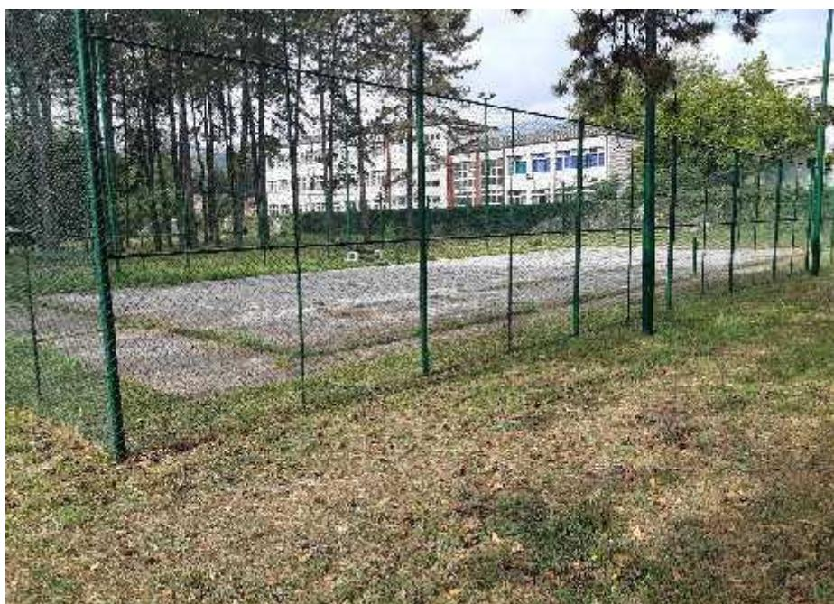
Teniski teren je sa asfaltnom podlogom, koja se nalazi u jako lošem stanju. Teren je ograđen i ogradom dimenzija  $28 \times 16 \text{ m}^2$ , a samo tenisko igralište je dimenzija  $23,77 \times 10,97 \text{ m}^2$ . Teren nema adekvatno osvjetljenje i nije oivičen betonskom soklom.
