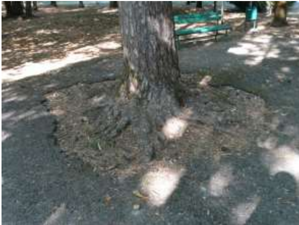
Slika 23. Asfalt hodne linije oko drveta
